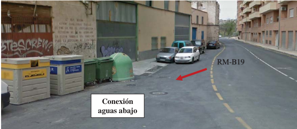
Figura 1. 11. Punto de vertido de la red de saneamiento en el PK0+404 del presente proyecto.
