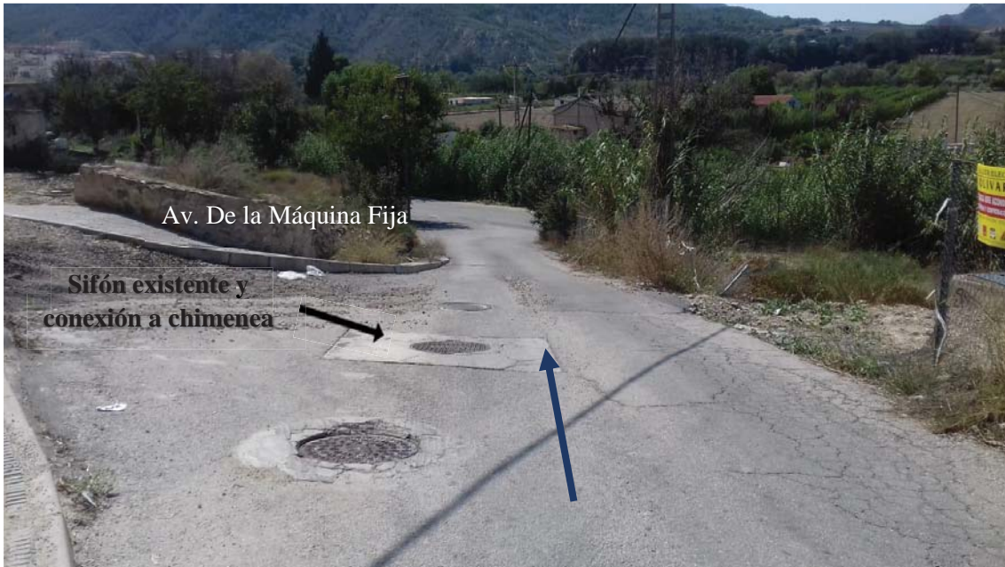
Figura 1. 3. Continuación en Av. De la Máquina Fija. En este cruce, Pk 0+035, existe un sifón, y en el margen izquierdo una chimenea conectada a la red. Vista hacia aguas abajo.
