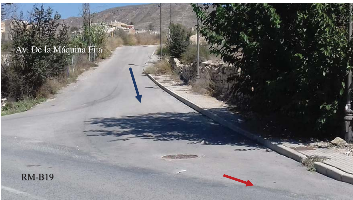
Figura 1. 4. Pozo de registro donde conecta el colector de 400 mm de la Av. De la Máquina Fija con el de 600 mm de RM-B19. Vista hacia aguas arriba.
