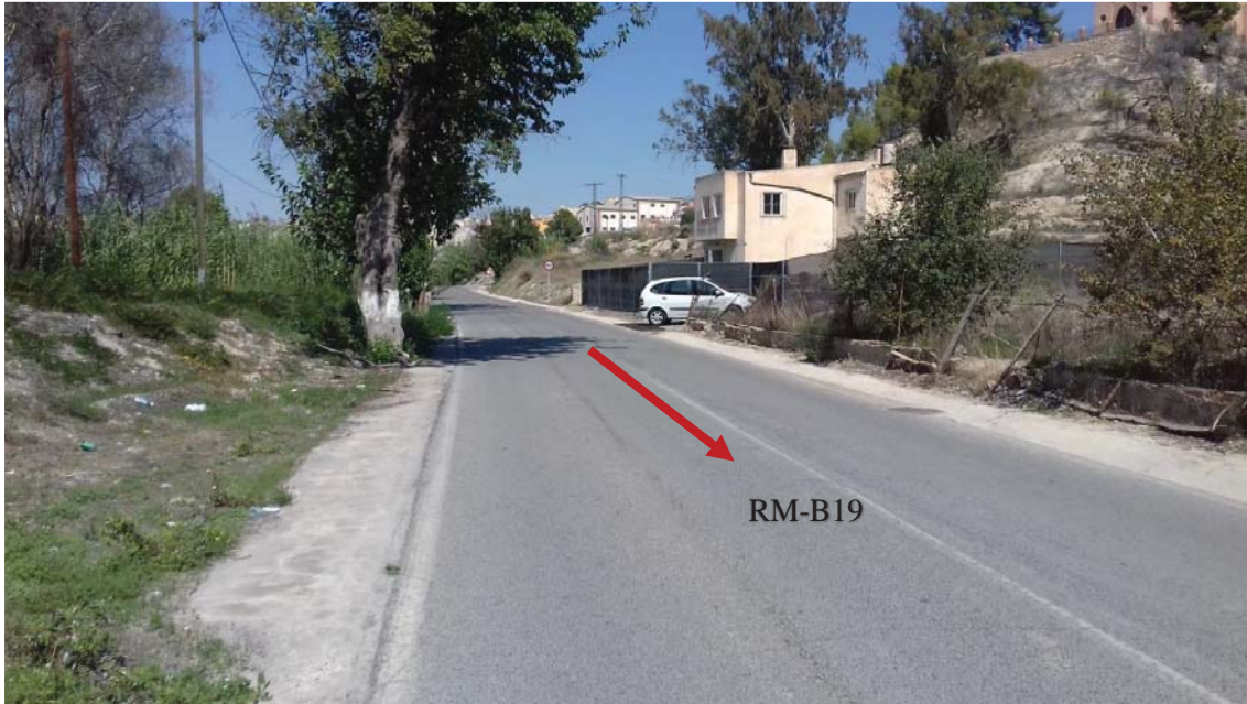
Figura 1. 7. Continuación en carretera RM-B19. Vista hacia aguas arriba.
