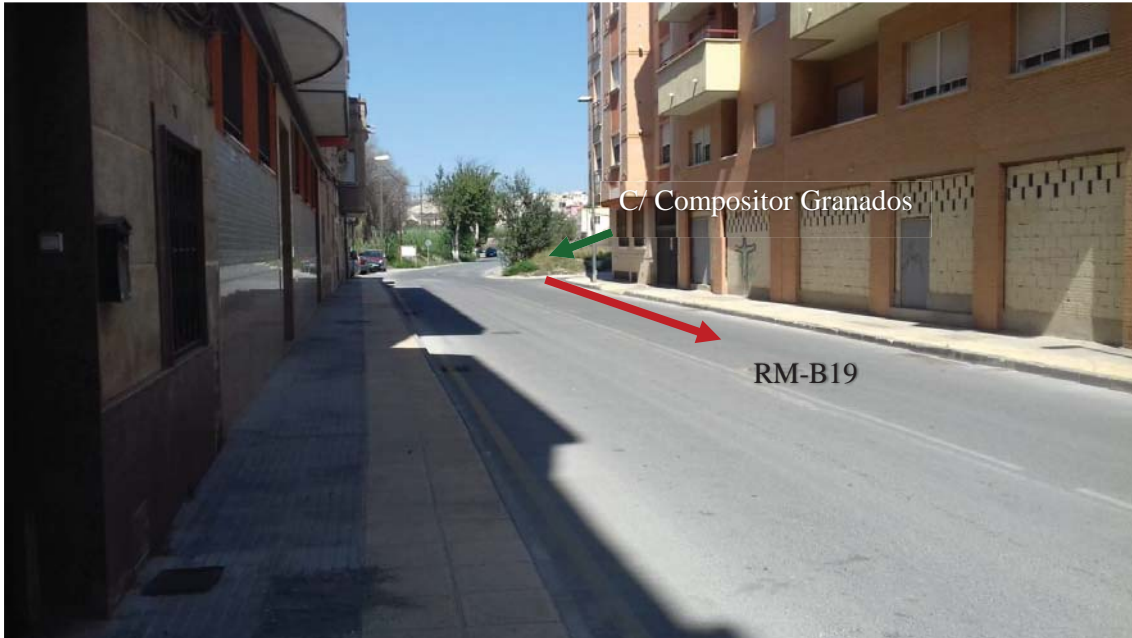
Figura 1. 9. Conexión de la carretera RM-B19 con calle Compositor Granados. Vista aguas arriba.
