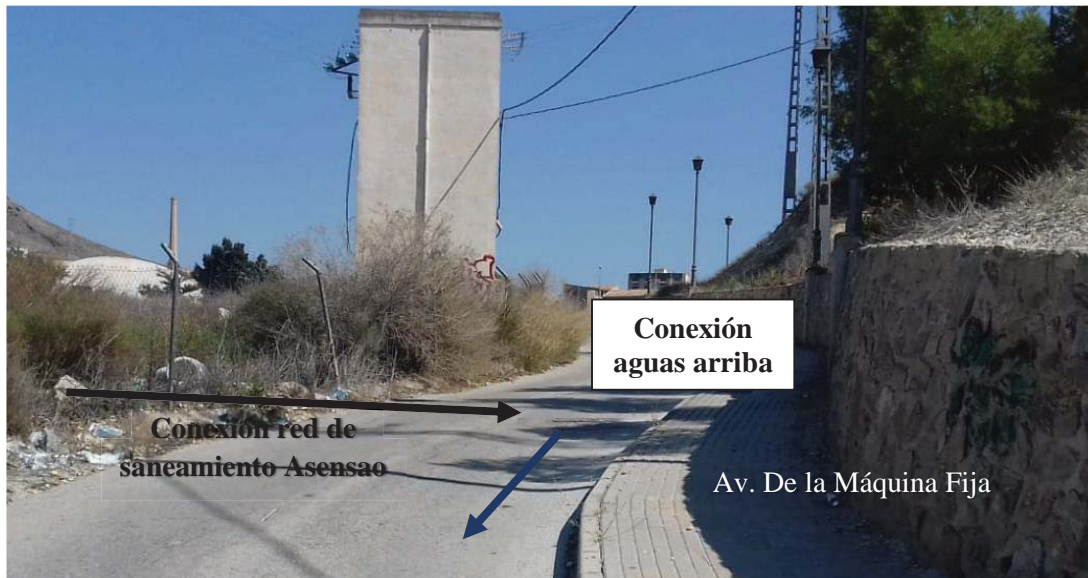
Figura 1. 1. Pozo de registro donde se conecta en el PK 0+000 el colector a proyectar en el presente proyecto en Av. De la Máquina Fija. Vista hacia aguas arriba.
